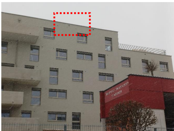
3 Stk Mauersegler WDV-Einbaukasten 1 A,; Ostfassade Stiege 3 (09.01.2026)
