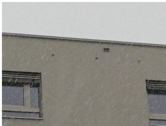
Detail, 3 Stk Mauersegler WDV-Einbaukasten 1 A,; Ostfassade Stiege 3 (09.01.2026)
